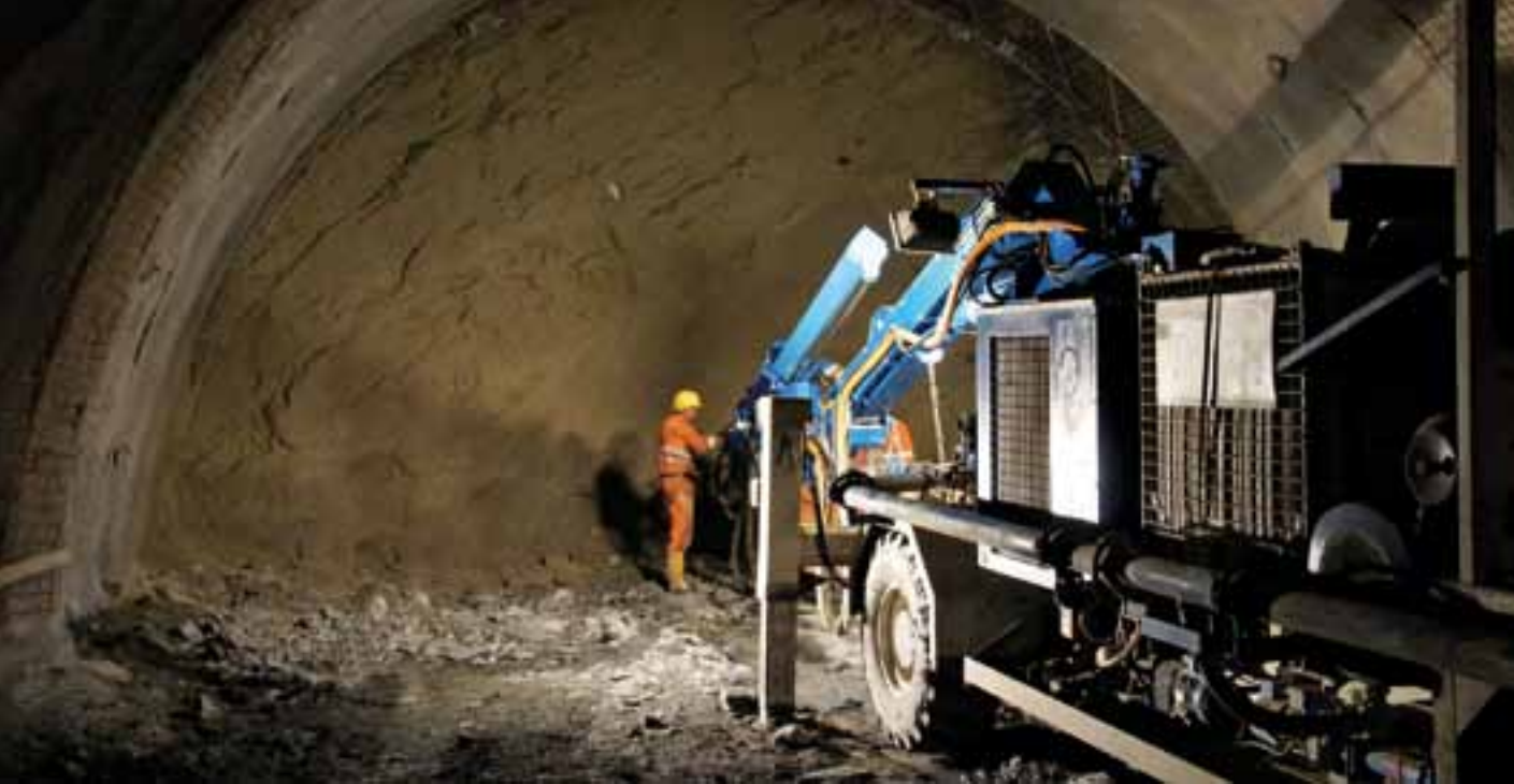
Lavori alla galleria di accesso Wolf
