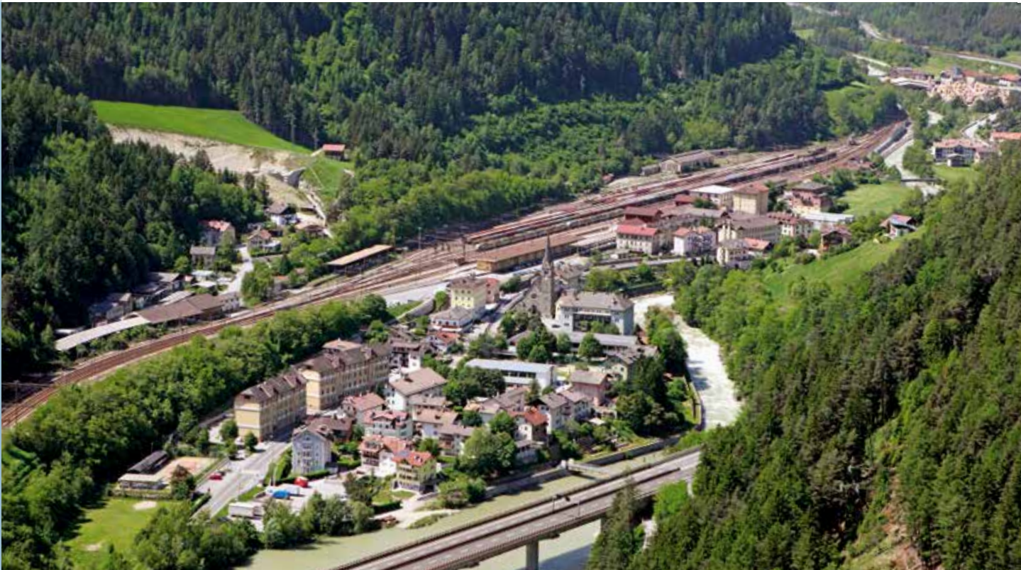
A sud della stazione di Fortezza inizia la galleria che porta verso sud a Ponte Gardena.
